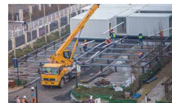
绿地大基建旗下天津建工集团承建天津代谢病医院，水电安装布管和箱式模块房吊装交叉作业。
